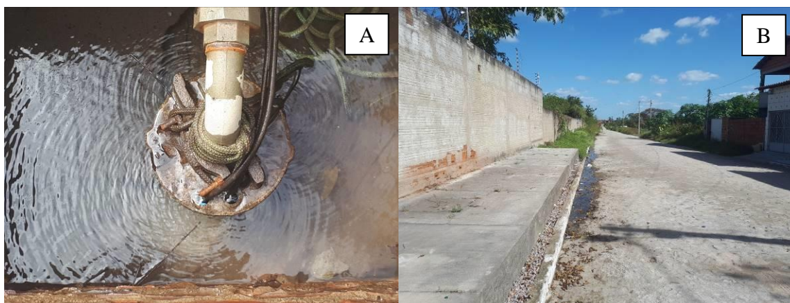
Figura 8 - Poços jorrante a ser estudado: A) Água vertendo sobre a cabeça do tubo; B) Rua lateral por onde a água do poço escoa (desperdiçada).
