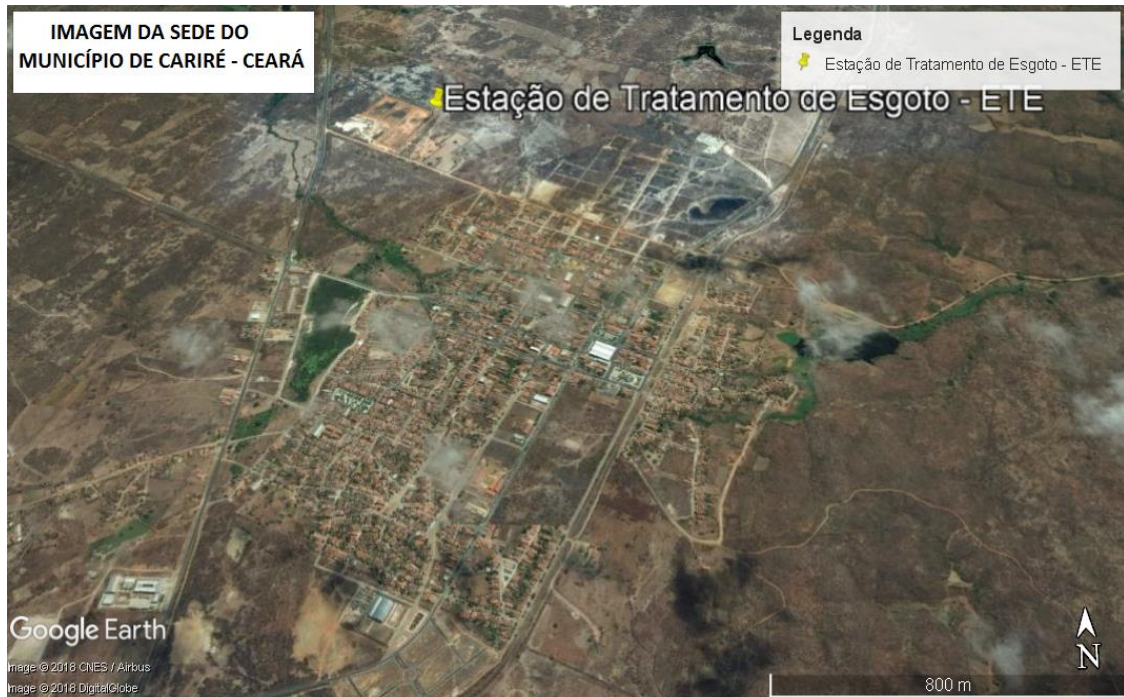
Figura 2 – Imagem de Satélite – Sede do município. Com legenda da localização da Estação de Tratamento de Esgoto – ETE
