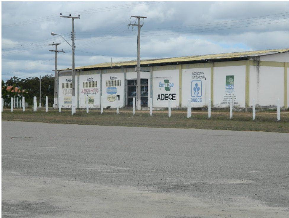
Figura 4 - Galpão de apoio aos irrigantes do Distrito de Irrigação Baixo Acaraú-CE
