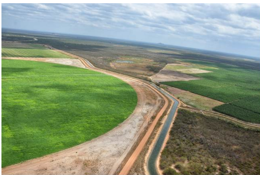
Figura 1: Projeto de Irrigação – Tabuleiro de Russas – CE
