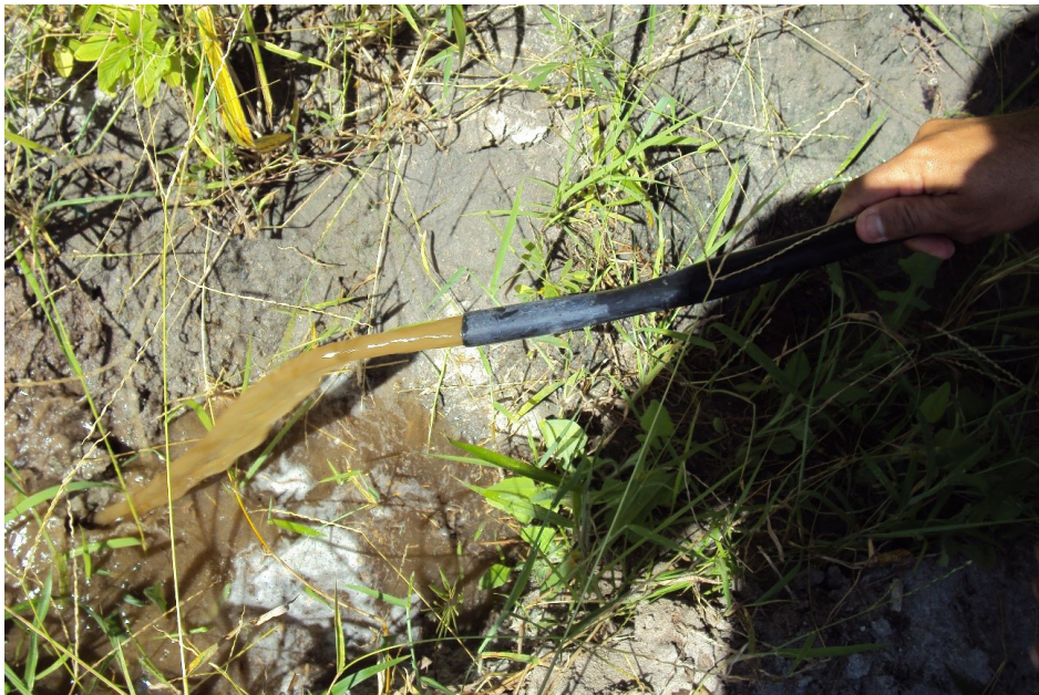
Figura 7 - Descarga da água das linhas de distribuição para a lavagem dos sistemas de irrigação localizados
